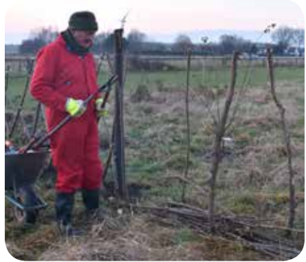
Fascine en cours de réalisation - photo personnelle
