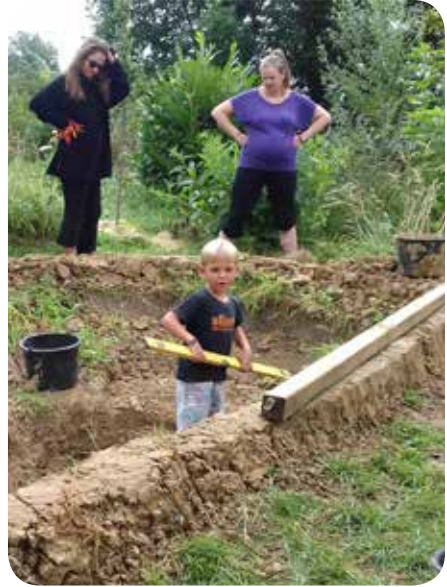
Vérification du niveau des berges - photo personnelle
