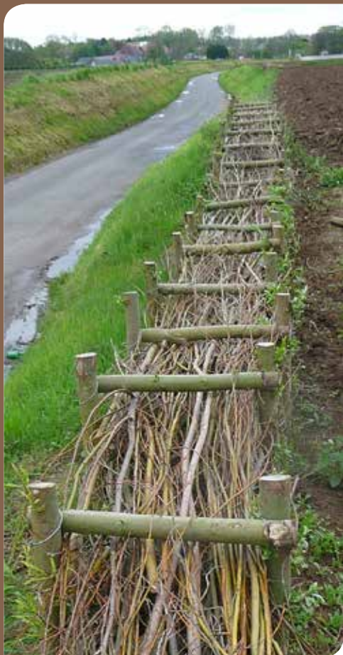
Fascine retenant des terres agricoles - www.tousazimuts.org
